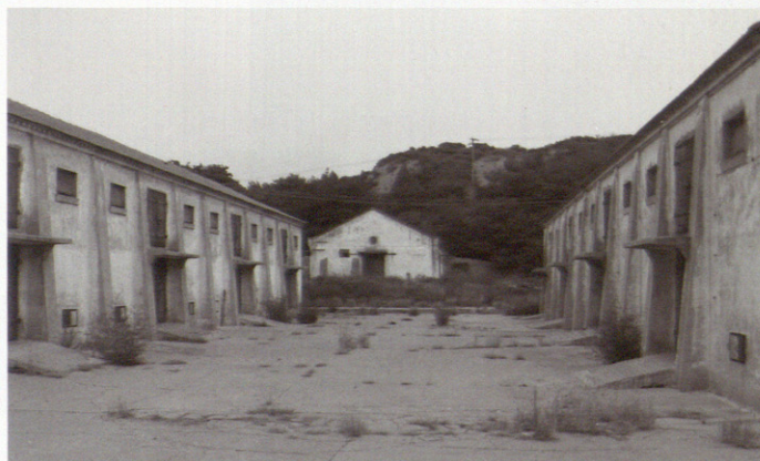
Estado inicial de las naves pre-existent que constituyen la base del nuevo museo. Initial state of the pre-existing warehouses that make up the base of the new museum.
